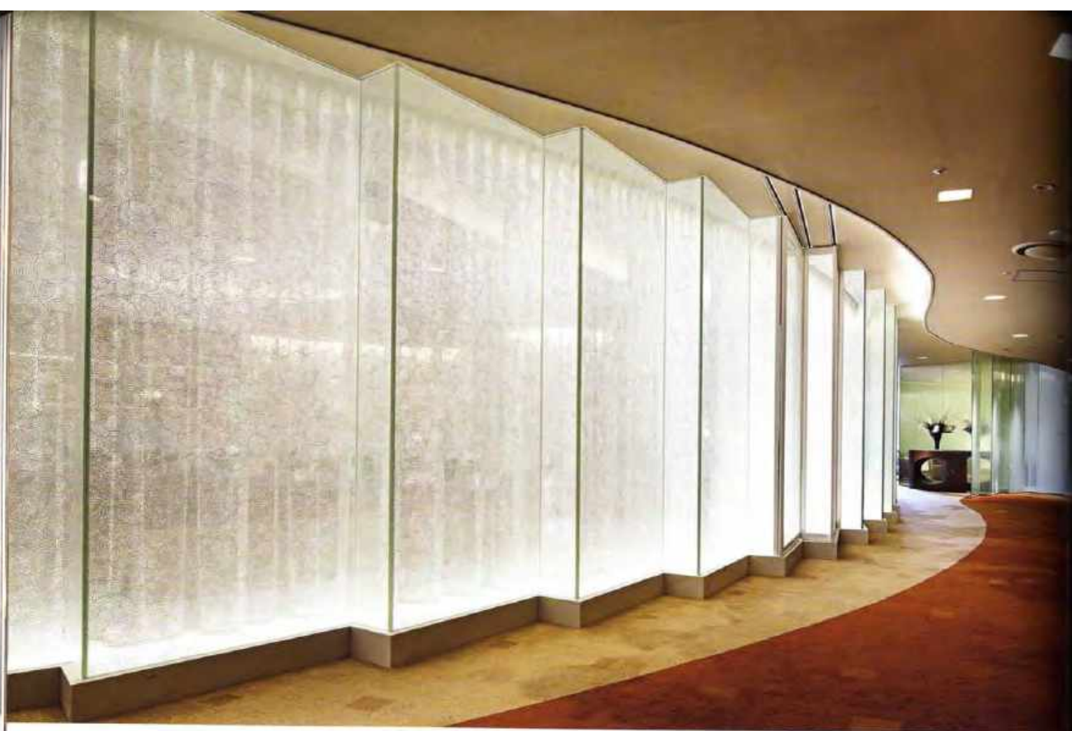
チャペルを囲むガラス壁に挟み込まれた生地とカーテンには、波紋が描かれている
